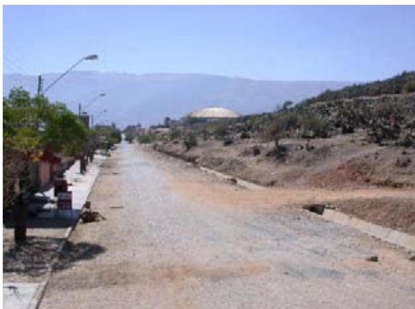
前面道路の状況
