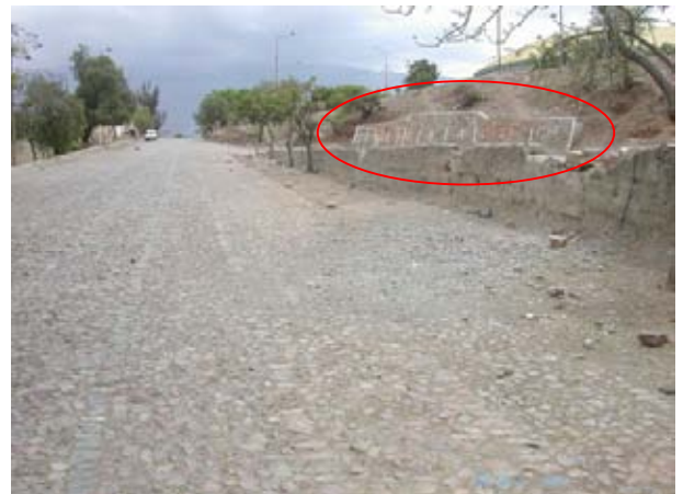
敷地内の擁壁
