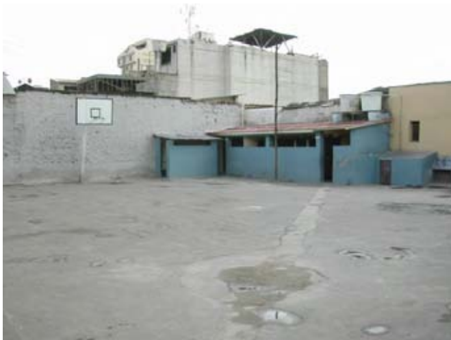
別棟のトイレ棟
