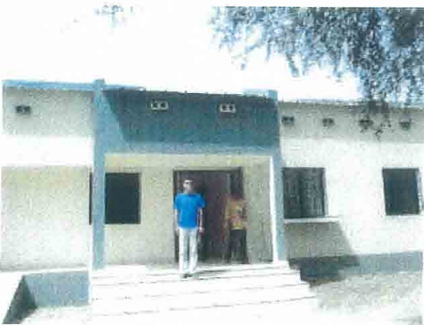
東部地方保健局ガイエリ保健行政区事務所。
