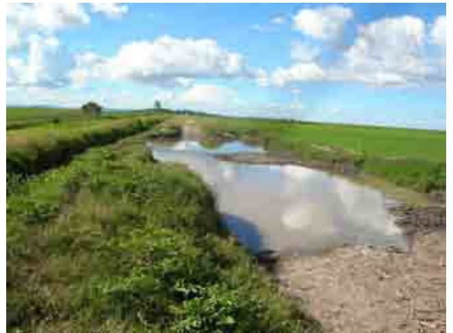
2次排水路沿いの農道 (R3) 路面の凹部に、水が溜まっている
