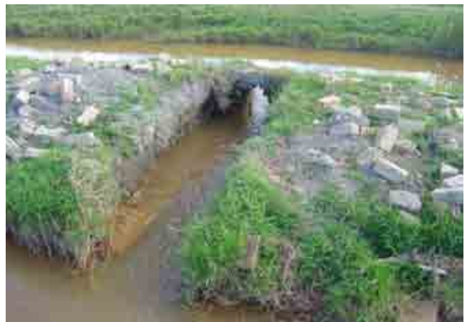
1次水路 (C5.5) の堤体 水路堤体を開削して取水している
