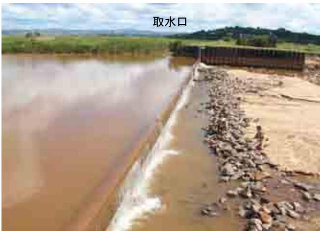
サハベ頭首工の堰体と取水口
