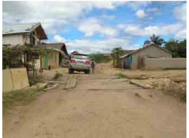
農道 (R1) 老朽化した木製橋梁
