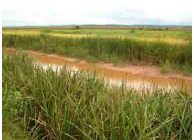
幹線用水路 (P5) の上流部 水路法面底部への堆砂が目立つ
