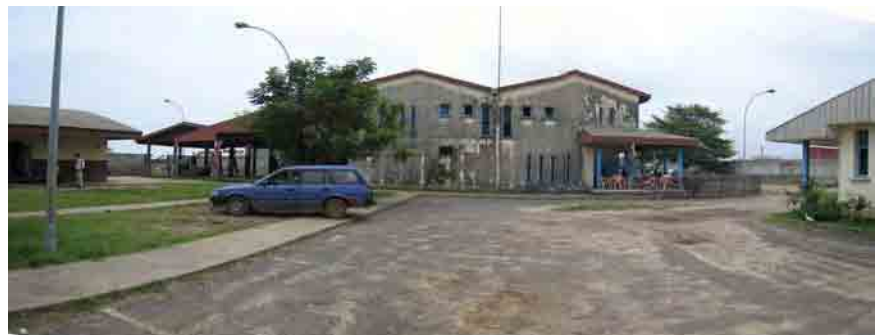
■ オウエンド漁民センター（CCPO）の全景。1984 年、EU と伊の共同で設立。2002～04 年、OFCF により製氷機が全交換された。
