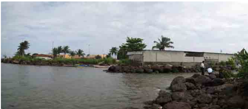
■ オルミ水揚場へ通じる水路の河口部。二股に見えるが、手前側が水路で奥がミッシェル・マリンの第2スリップウェイ。一帯は遠浅状態である。
