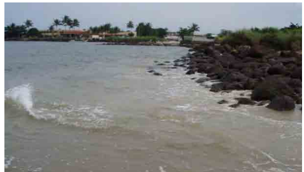
■ 計画サイトの海岸部：写真奥がミッシェル・マリンのリゾート施設で、右手海岸部には捨石護岸が見える。護岸の裏手にオルミ水揚げ場へ向かう水路があり、漁船が通航する。透明度は悪い。
