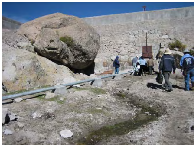
写真12： 同計画(3)。 以前は石積みダムで老朽化しており、漏水が酷かった。この漏水を防ぐため、基礎工を4m掘り、鉄筋コンクリートにし、水門橋の改修を行った。
