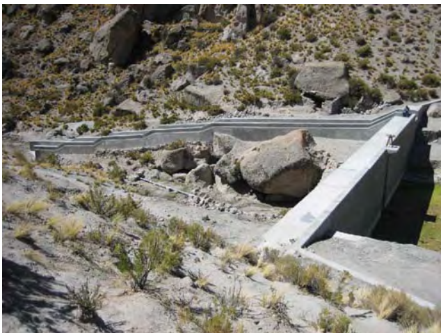
写真11： 同計画(2)。 完成した貯水堰堤及び排水溝。
