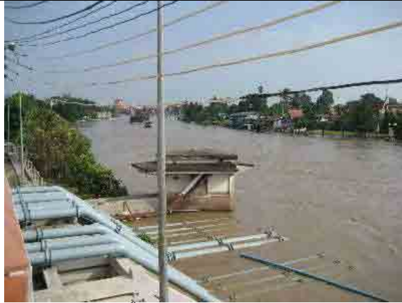
ภาพถ่ายโรงกรองน้ำประปาของเทศบาลนครพระนครศรีอยุธยา
