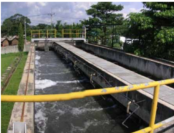
แหล่งบำบัดน้ำเสียซึ่งดำเนินการโดยจ.พระนครศรีอยุธยา ตั้งอยู่ใน เขตแม่น้ำ ลพบุรี บนพื้นที่จ.พระนครศรีอยุธยา
