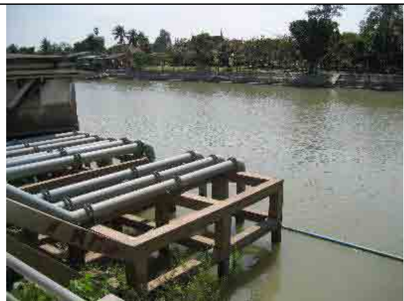
ภาพถ่ายโรงกรองน้ำ เทศบาลนครพระนครศรีอยุธยา
