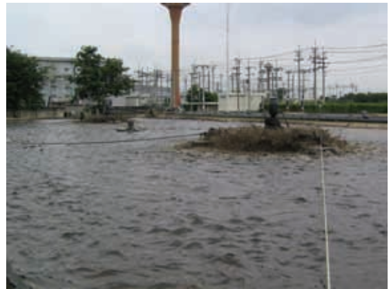
アユタヤ県ロジャナ工業団地の排水処理池。処理水の水質はPCDの排出基準に適合していた。
