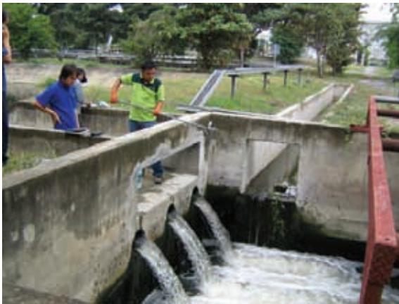
アユタヤ県のロジャナ工業団地の排水処理場出口での水質分析のサンプリング。
