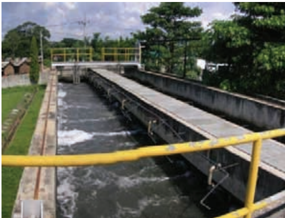
アユタヤ市が運営する下水処理場、ルップリ河沿いに位置する酸化処理方式の処理場。アユタヤ市の面積比50%、人口比70%を処理し、公称25,000ton/dayの能力をもつ。
