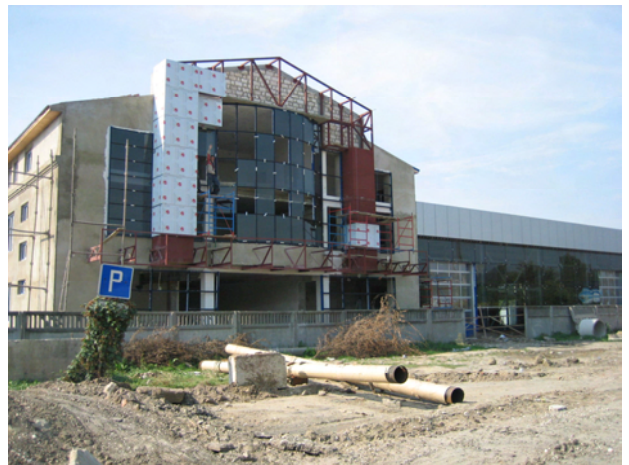
写真 6 PIU の隣接地に建設中の農業機械化訓練センター
