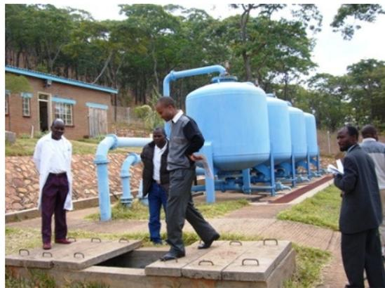
中央地域水公社 Mchinji 水道の浄水場。基本的設計はチョロ水道と類似している。
