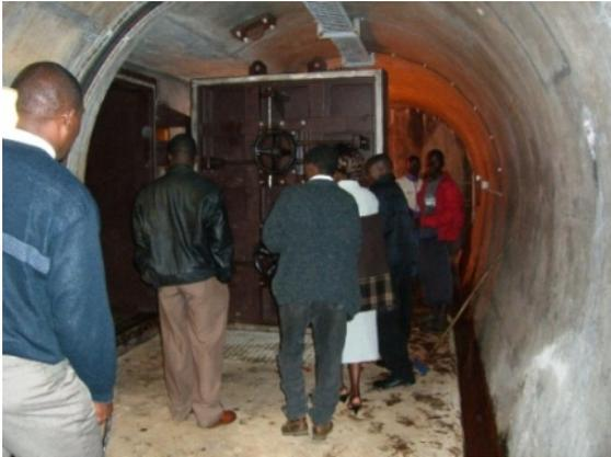
Mulunguzi ダム管理用トンネルから取水塔に入る。耐圧扉ゲージは 600kPa まで設定。
