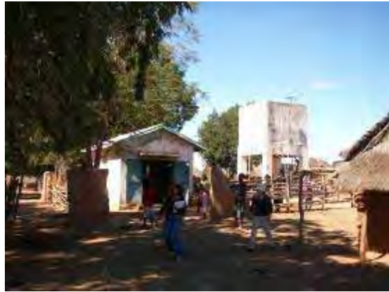
Andranahinaly Fukutan (パートナーサイト) レベルIIのサイトで稼動中である。しかし、給水人口の増加で、発電機が24時間運転となっている。
