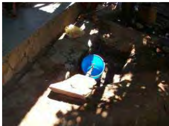
Shakaraha 2 各戸給水 各戸給水が行われているが給水人口増加により、水量不足となり、6-7 時と 17-18 時だけ給水が行われている。
