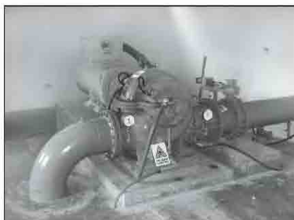
FIGURA 11. BOMBA QUE OPERA COMO TURBINA
