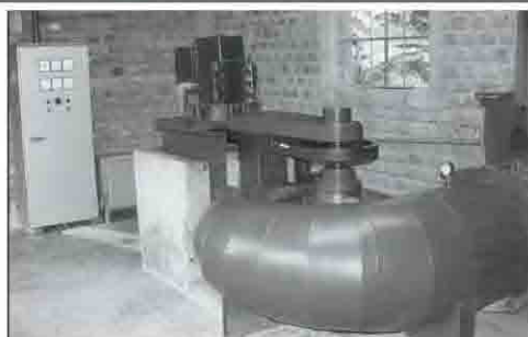
FIGURA 21. TURBINA AXIAL DE 25 KW DE EJE VERTICAL CON SISTEMA DE TRANSMISIÓN DE 2:1 POR MEDIO DE FAJAS Y POLEAS
