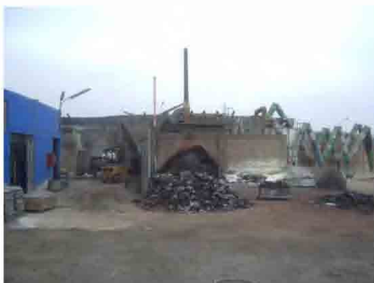
Figura 5.4 Fabrica de plomo de baterías usadas
