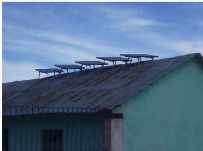
Figura 1.9 Sistema Fotovoltaico para carga de baterías
