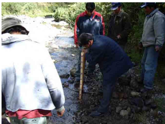
Fotografía III-3.5.1-8 Instalación del Limnómetro
