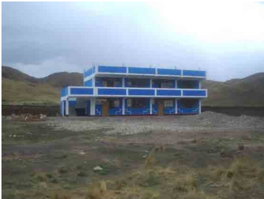
Nuevo módulo de aulas
