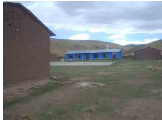
Módulo de aulas en uso, módulo 1 (fachada), 2 (parte posterior)
