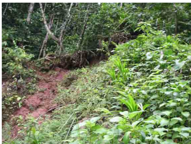
Fotografía III-4.5.1-4 Deslizamiento en la Ruta
