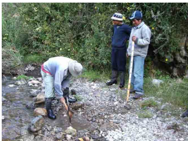
Fotografía III-3.5.1-7 Instalación del Limnómetro
