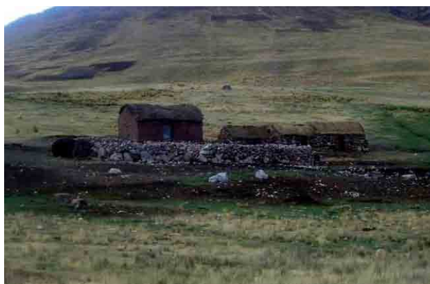
Fotografía III-1.5.1-2 Vivienda Construida con Ladrillos de Adobe
