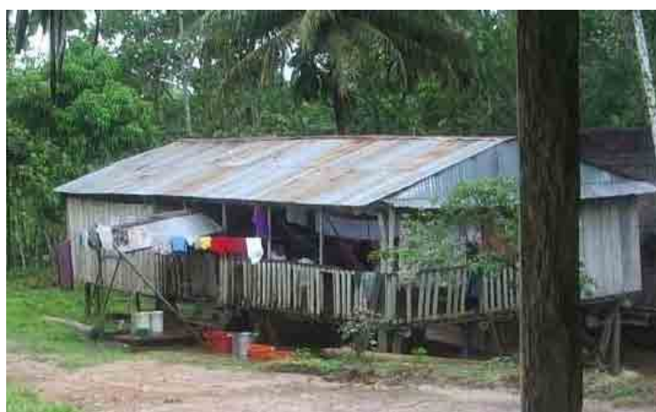
Fotografía III-2.5-3 Estructura Abierta de una Vivienda Típica
