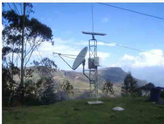
Figura 1.12 Sistema Fotovoltaico en Telecomunicaciones
