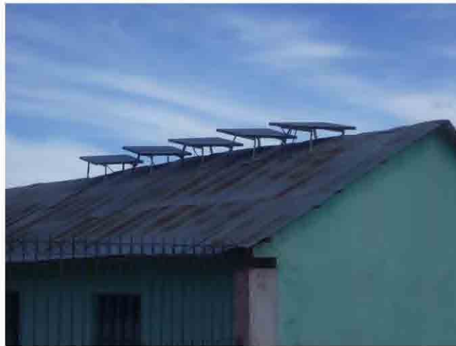
Figura 1.9 Sistema Fotovoltaico para carga de baterías
