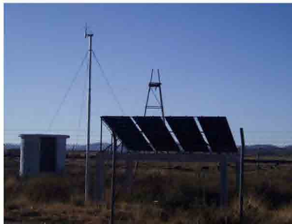
Figura 1.10 Sistema de Bombeo Fotovoltaico
