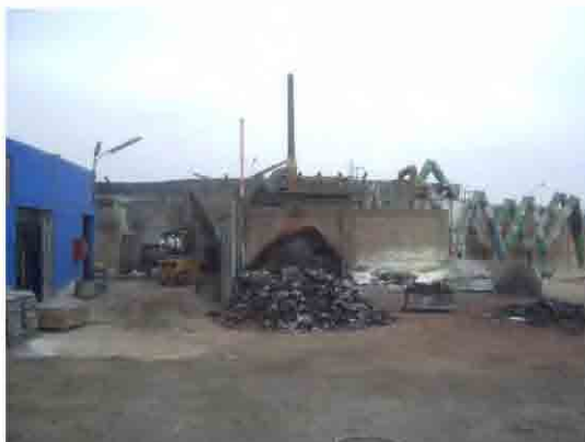
Figura 5.4 Fabrica de plomo de baterías usadas
