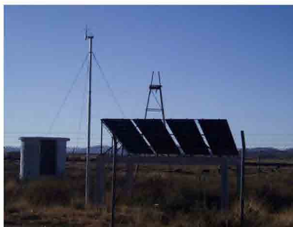
Figura 1.10 Sistema de Bombeo Fotovoltaico
