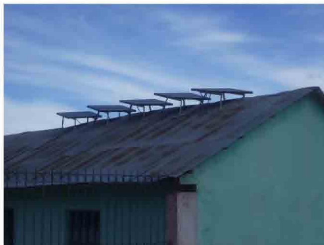
Figura 1.9 Sistema Fotovoltaico para carga de baterías
