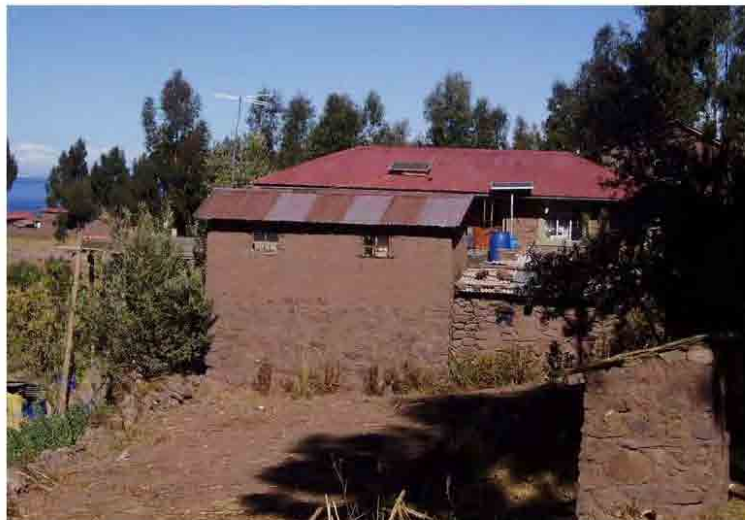
Figura 1.8 Sistema Fotovoltaico Domiciliario (Isla Taquile)
