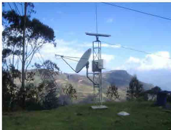
Figura 1.12 Sistema Fotovoltaico en Telecomunicaciones
