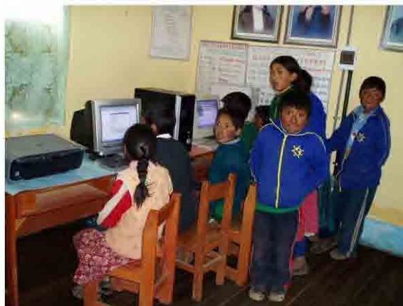
Figura 1.11 Sistema Fotovoltaico en Escuelas Rurales
