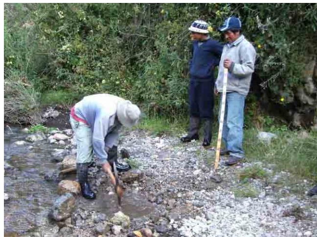
Photo III-3.5.1-7 量水標設置状況
