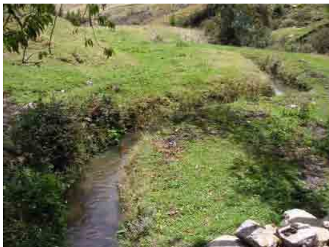
Photo III-3.5.1-17 既設灌漑用水路
