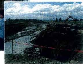
放水路の掘削工事中
