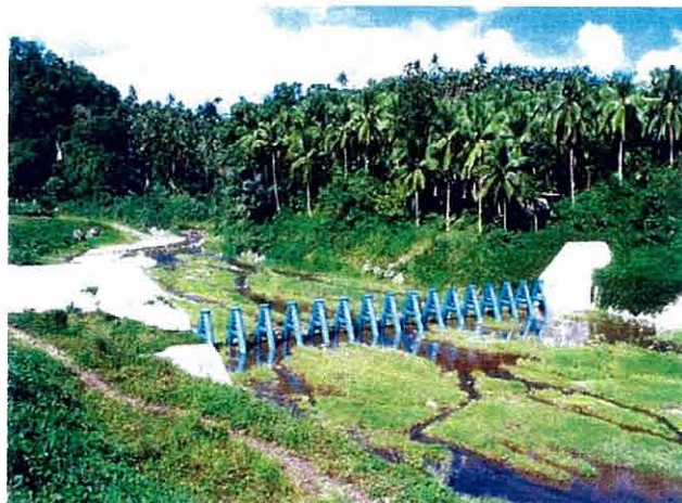
写真4.1.2 流木を捕捉するスリットダム
