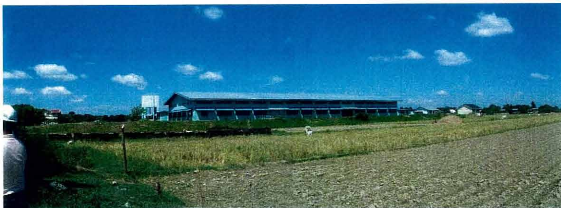
写真4.1.7 避難センター全景（増水時を考慮して盛土の上に建設してある）
