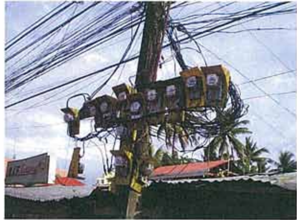
図3-4 柱上メータリング方式
