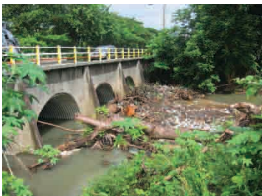
写真 市街地北の橋梁にごみ等が堆積している状況、右は遊水地上流部の状況 流入水路が狭いためにゴミ等で閉塞しやすい
