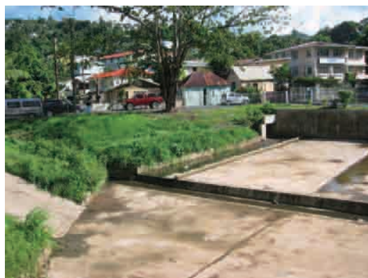
写真 市街地北の橋梁にごみ等が堆積している状況、右は遊水地上流部の状況 流入水路が狭いためにゴミ等で閉塞しやすい
