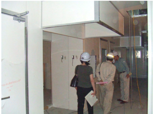
ハイテクセンター建設現場
