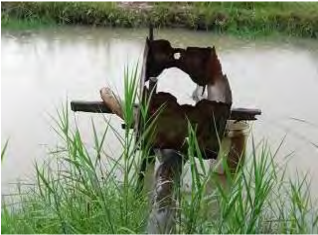
川の上に設置された家庭用トイレ
