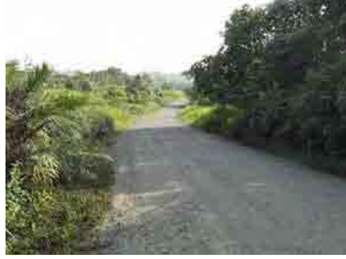
写真4 ネットン変電所からココサイ変電所間の道路2
