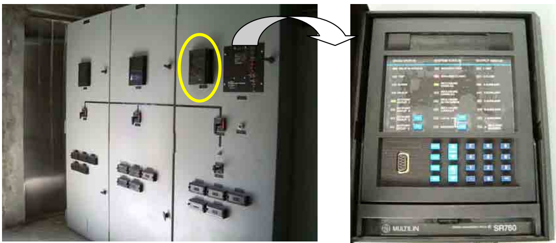
図 2.4.2-23 保護継電器
