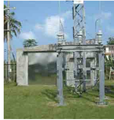
図 2.4.2-9 アイライ変電所（建屋）
