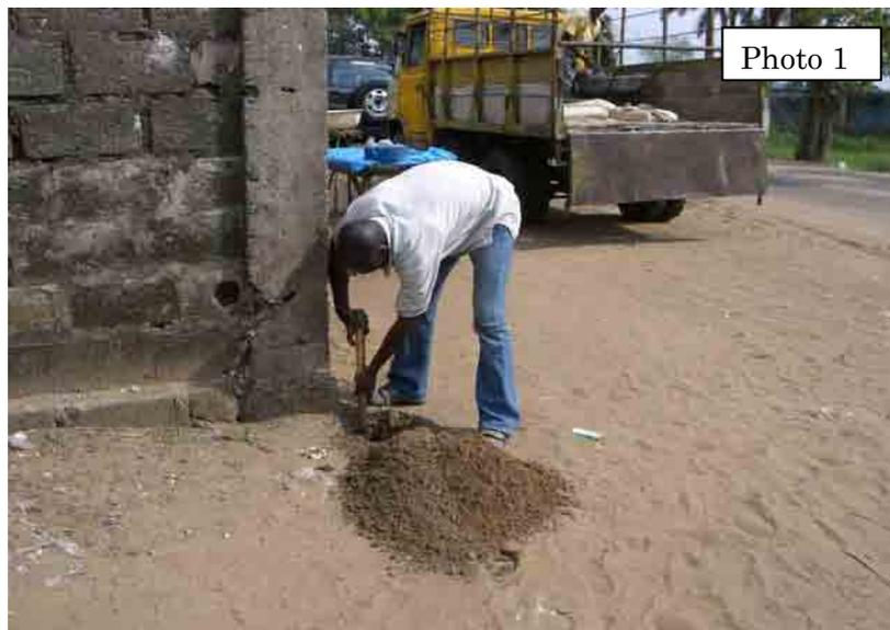
Marquage d'un point de contrôle sélectionné GPS 3.
