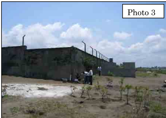
Un point sélectionné dans un coin d'un mur en béton. (GPS 21)
