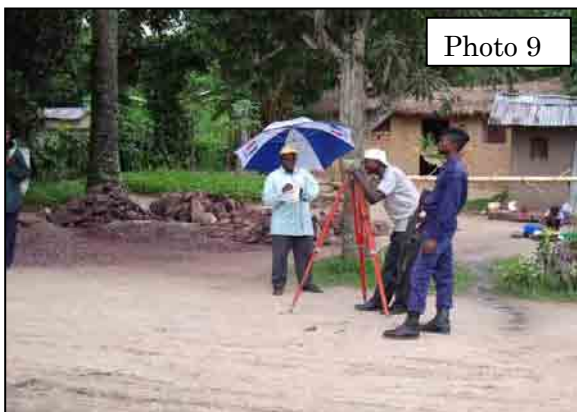
Observation de Nivellement
