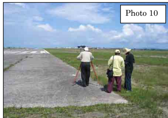
Observation de Nivellement à l'Aéroport International
