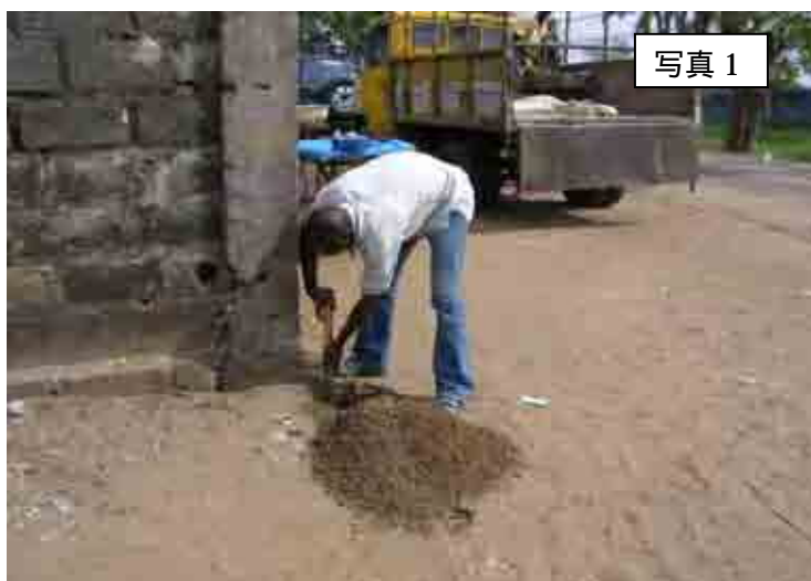
コンクリート固定による測量鉞の設置作業。鉞を埋めるため地表に深さ0.5mの穴を掘る。点の命名を行う。（GPS3）
