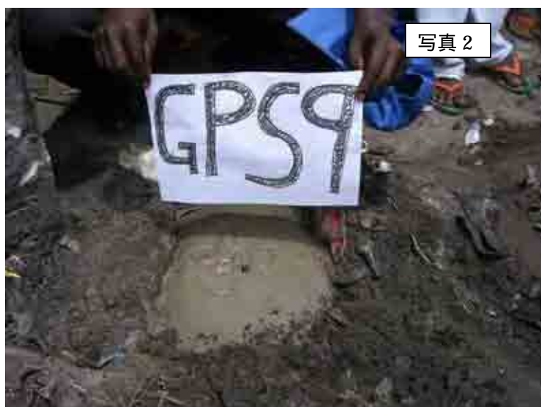
設置した基準点(GPS9)
