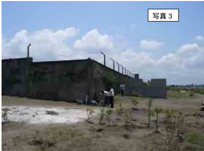
コンクリート壁の角に選んだ点
