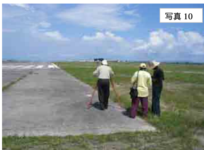
国際空港内での水準測量作業
