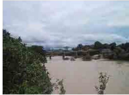
Thnuos Luong (Kampong Speu Bridge)
