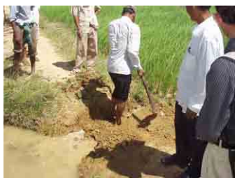
(a) 違法パイプの撤去
