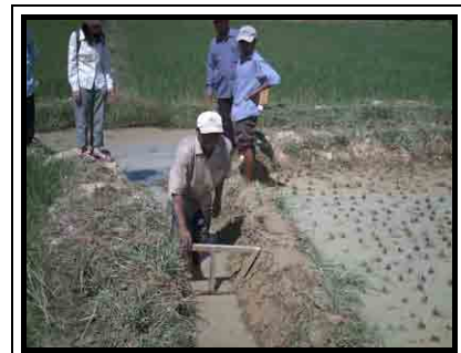
末端水路の建設/改修の検査方法
