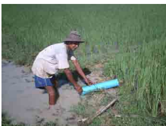
(a) PVC パイプの設置
