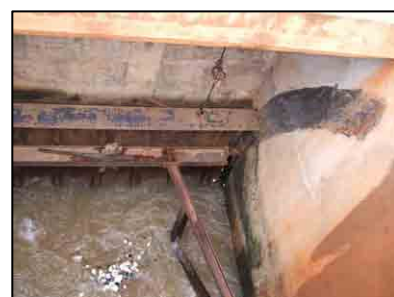
バットクローチ取水ゲートの仮修復
