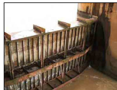
ローレンチェリ頭首工のゲート下流側からの光景
