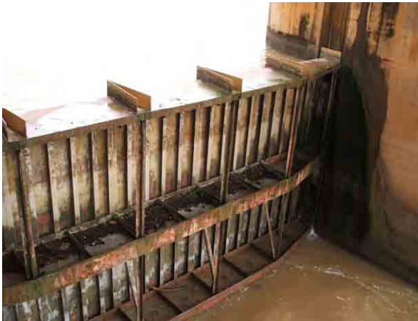
ローレンチェリ頭首工ゲート (下流側から見たローレンチェリ頭首工ゲート)
