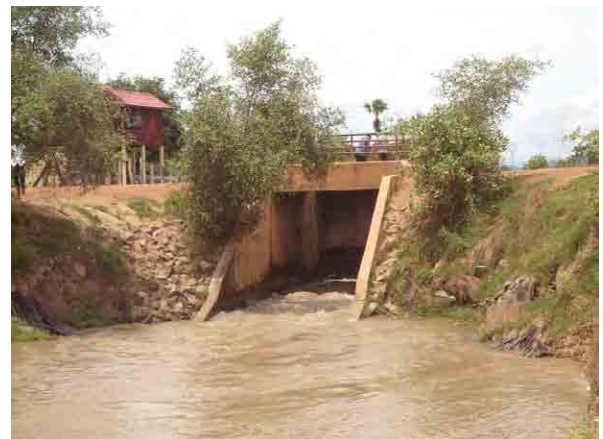
バットクローチ取水工と南導水路 (バットクローチ取水工下流左岸からの全景)
