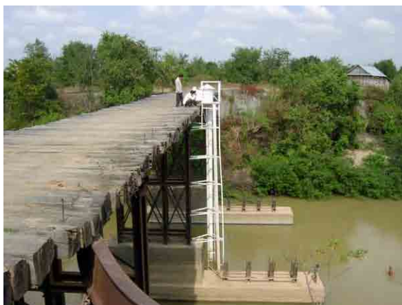
水位計の設置作業 (Peam Khley に設置)
