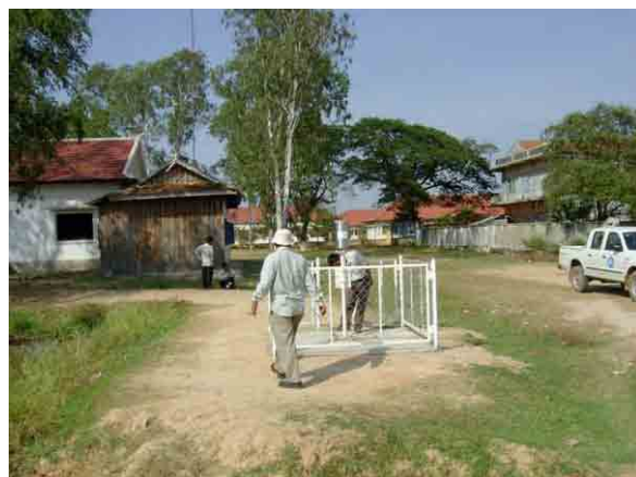
雨量計の設置作業 (Kong Pisey に設置)
