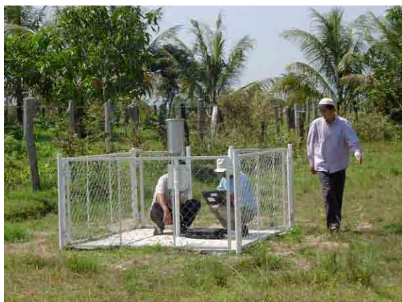
雨量計の設置作業 (O Kom Trom に設置)
