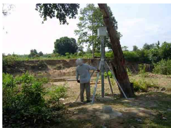
水位計の設置作業 (Sangkea Tasal に設置)
