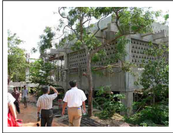
建設中の新博物館
