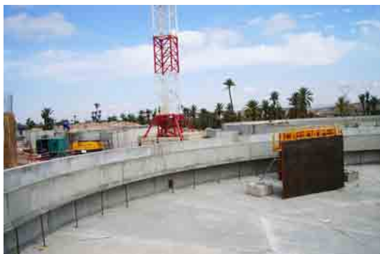
Station de traitement des eaux usées en cours de construction
