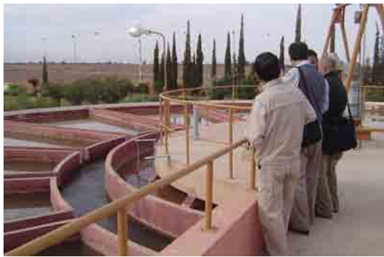
Station d'épuration d'eau de Marrakech
