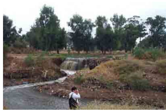
Sewage Discharge Site
