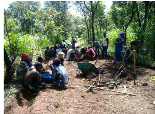
道路改修を行う住民
