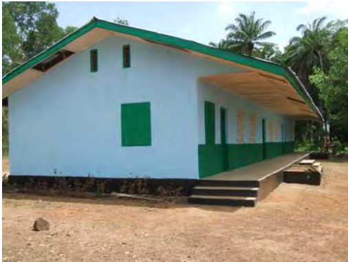
3教室＋事務所＋倉庫建設
