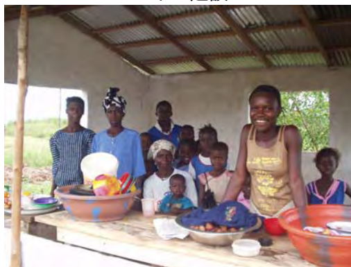
生徒に食べ物を売る女性のための小屋建設
