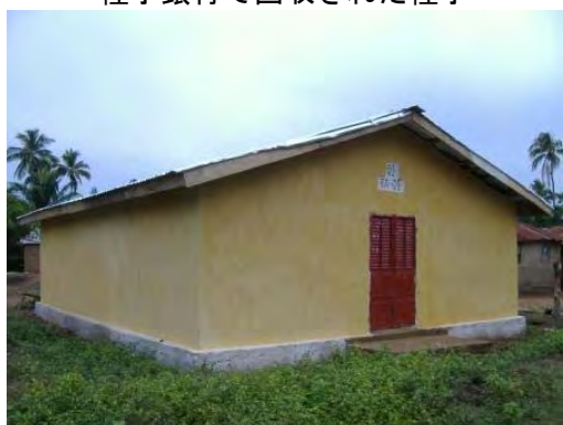
コミュニティ種子倉庫建設
