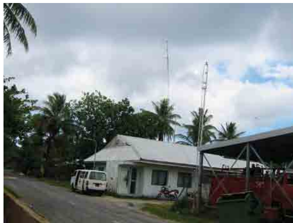
TMD ラジオ スタジオ局舎(後方の白い建物) 屋根の後方に見えるのは FM 放送用のアンテナ
