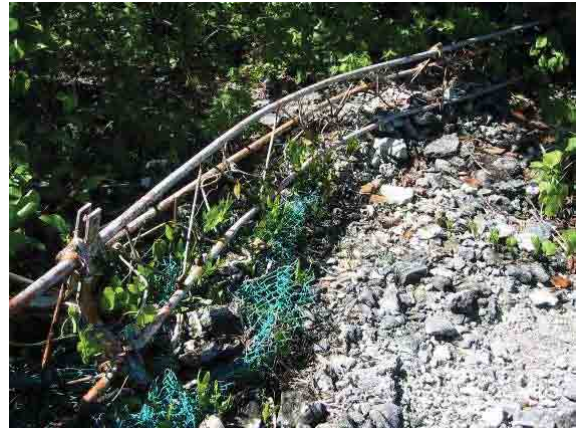
倒壊したアンテナ・マスト
