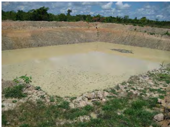
FP サイトの一つ、Phnom Preah Thet CF において建設された貯水池
