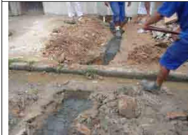
給水装置の修繕状況-3: 修繕工事完了後の砂による埋戻し
