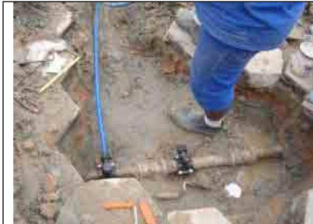
給水装置の修繕状況-1: 配水管と給水管の接続部の修繕状況
