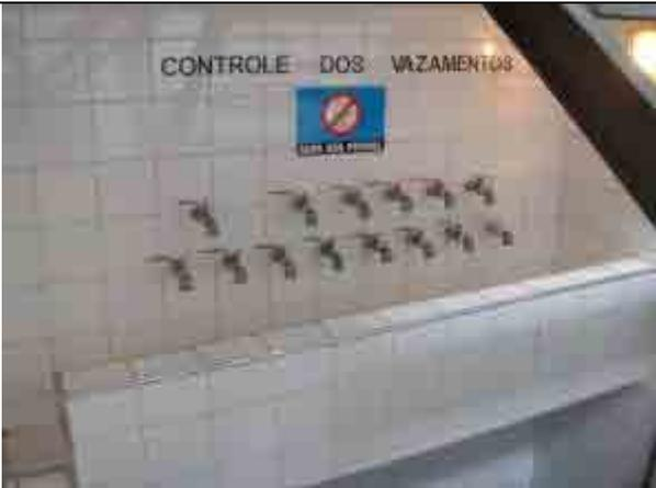
CEQ の模擬漏水発生室内：漏水発生用バルブ
