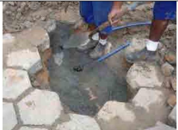
給水装置の修繕状況-2: 水管と給水管の接続部修繕工事後の埋戻し
