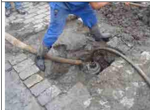
給水装置の漏水箇所修理状況-2: 漏水した水をポンプで排水
