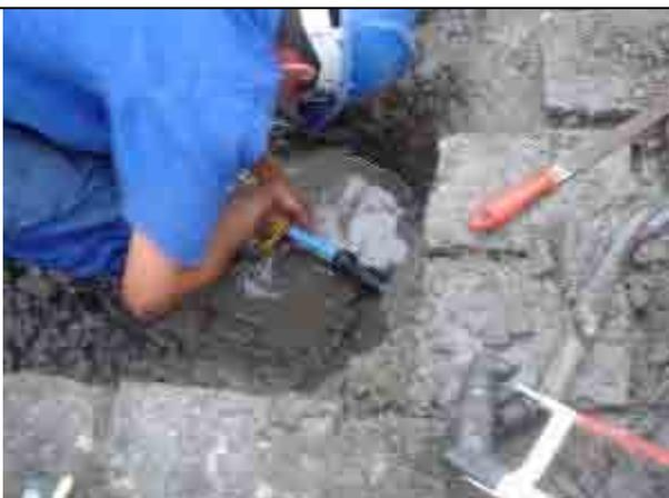
給水装置の漏水箇所修理状況-3: ポンプで排水後、漏水部分を修理
