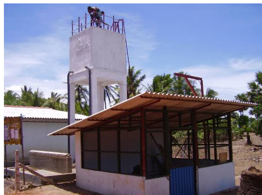
CMRによるコミュニティ水道の高架タンク 工事 (テーターワディ村)
