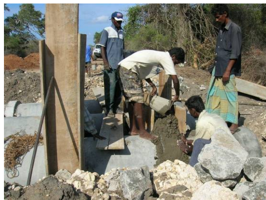
CMRによるクーライーシードゥウィナーヤカラム取り付け道路のカルバート工事 (クーライ村)
