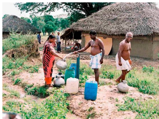
高架タンクなしで暫定的に稼動し始めたCMR 工事によるコミュニティ水道（パーリアール村）
