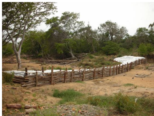
コンクリート基礎を利用し、CMR により木材とサンドバッグで完成した頭首工の仮堰（パーリアール村）
