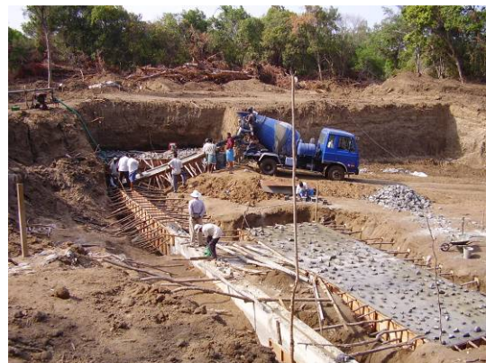
建設業者によるパーリアル頭首工の工事 (パーリアル村)
