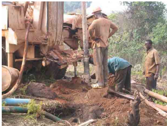
Photo 5 Forage avec un trépan tricône
