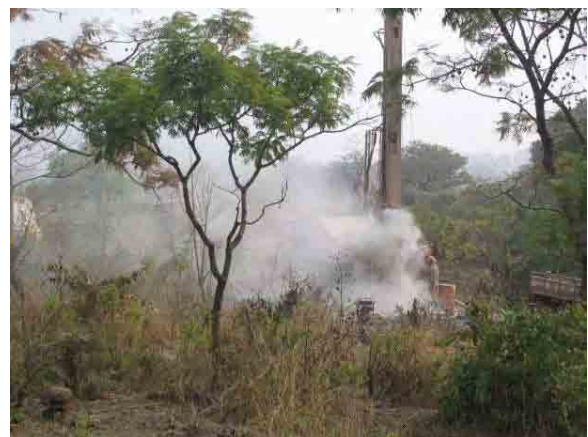
Photo 8 Forage au marteau pneumatique (b)
