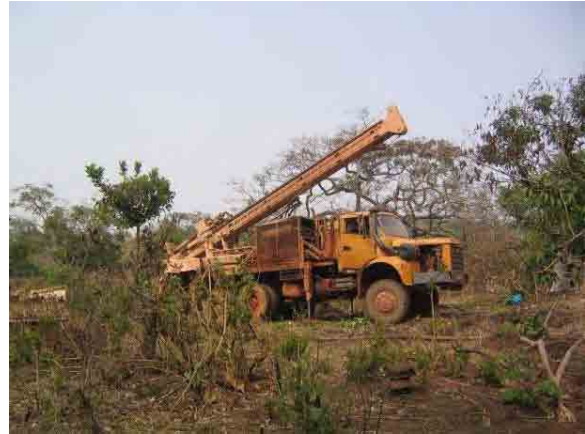
Photo 4 Installation de l'appareil de forage (b)
