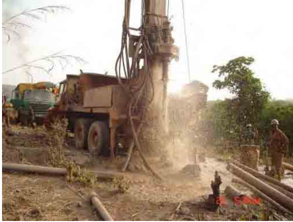
Photo 9 Forage de la zone fracturée (a) (condition dans laquelle l'eau souterraine jaillit)
