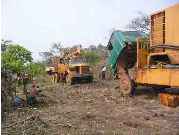
Photo 3 Installation de l'appareil de forage (a)
