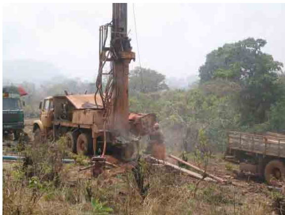
Photo 7 Forage au marteau pneumatique (a)
