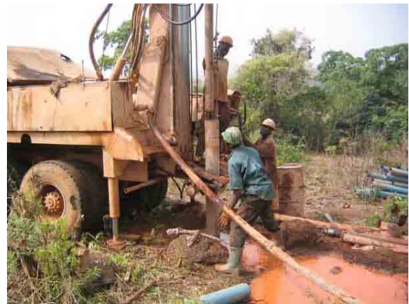
Photo 6 Insertion du tube guide
