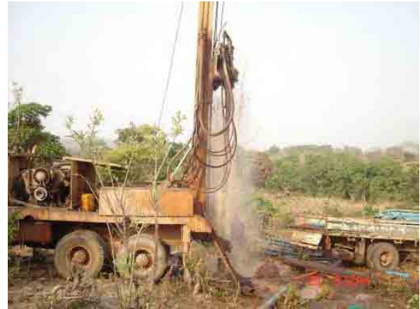
Photo 10 Forage de la zone fracturée (b) (condition dans laquelle l'eau souterraine jaillit)
