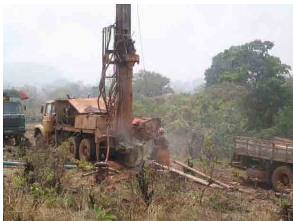
写真-7 エアーハンマーによる掘削(a)
