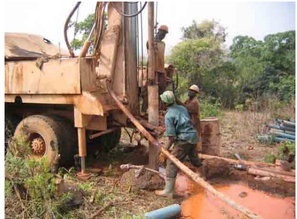
写真-6 口元管の挿入
