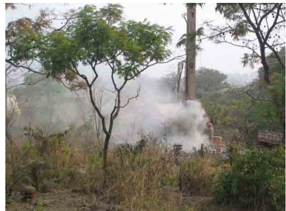
写真-8 エアーハンマーによる掘削(b)
