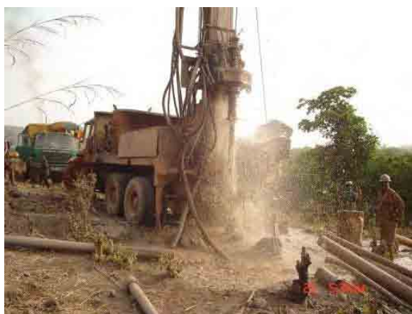
写真-9 破砕帯の掘削(a) (地下水が湧き出ている状態)
