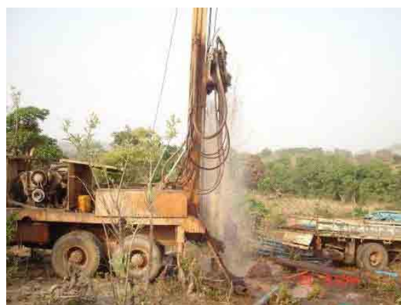
写真-10 破砕帯の掘削(b) (地下水が湧き出ている状態)
