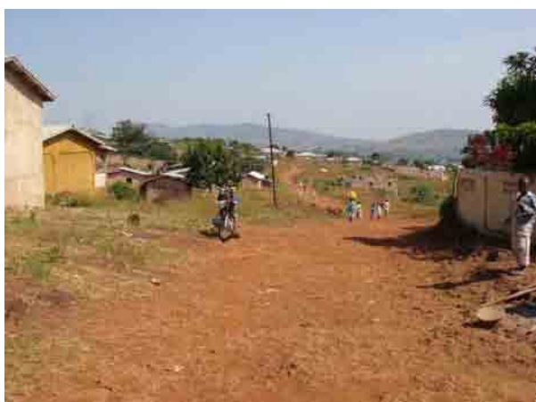
本計画地手前約1.2km付近。道路と言うような幅・縦断勾配などは勘案されておらず、道路としての機能性からも改良・修繕が必要である。
