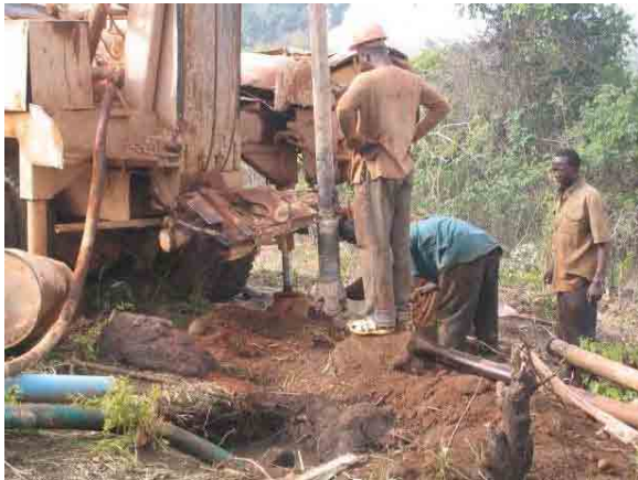
写真-5 トリコンによる掘削
