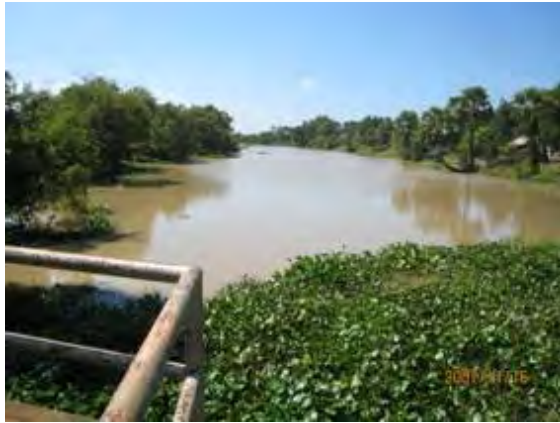
写真-15. アンドンスラ取水工の管理橋から見た同取水工上流側の状況（常時）。直上流は北導水路終点にあたる。
