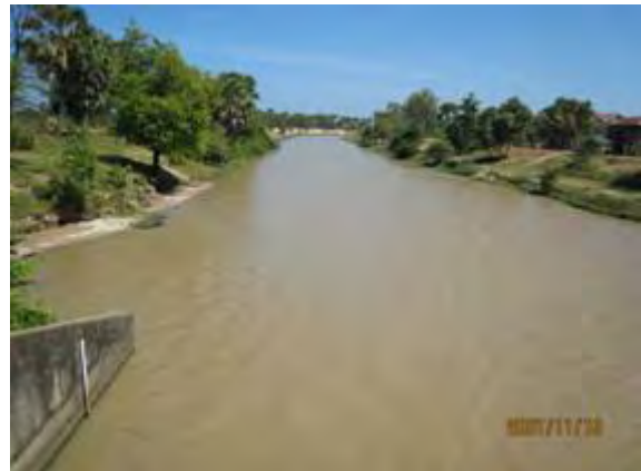
写真-16. アンドンスラ取水工の管理橋から見た同取水工下流側の状況（常時）。直下流は北幹線水路の始点にあたる。洪水時には既設取水工ゲート漏水に伴い、下流域で湛水被害が生じている。
