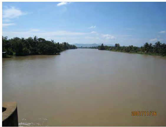
写真-3. 頭首工管理橋から見た頭首工上流部全景(常時)。計画堰上げ水位による上流湛水状況を示す。
