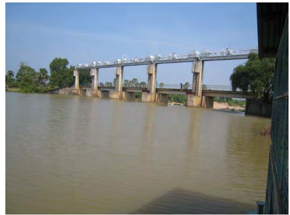
写真-2. ローレンチェリー頭首工の上流状況(常時)。常時計画堰上げ水位はWL. +35.70m(上流側計画水深 h=6.70\text{m} )である。
