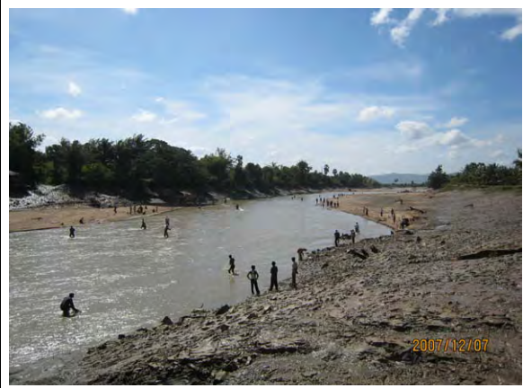
写真-4. 頭首工管理橋から見た頭首工上流部全景(ゲート開門調査時のゲート全開時)。ゲート開門調査時に、頭首工本体、上・下流の施設状況、水切り状況等の調査をした際に撮影した。
