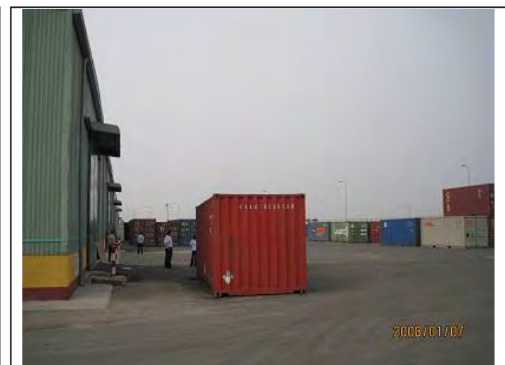
写真一 6 開披検査場建設予定地
