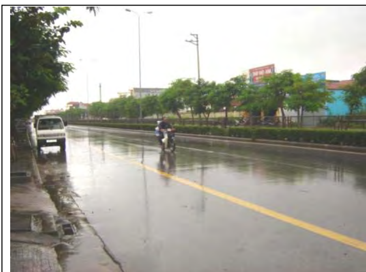
写真—11 ハイフォン X 線検査場予定地の前面道路 写真の左側が予定地。両側 4 車線で国道 5 号線とハイフォン港に近い。近い将来、市内環状高速道路に連結される予定。
