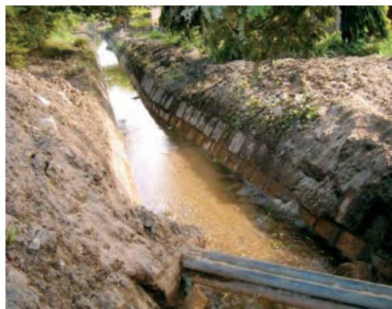
排水溝清掃後
