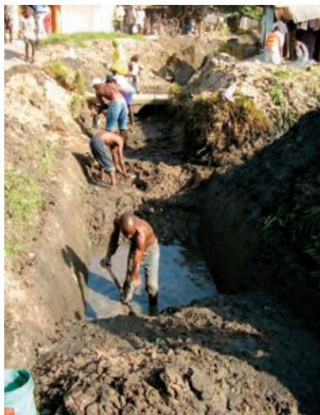
排水溝清掃中
