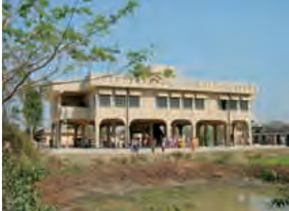
2001年2月に竣工した日本の無償資金協力により建設されたシェルター兼初等学校の例。
