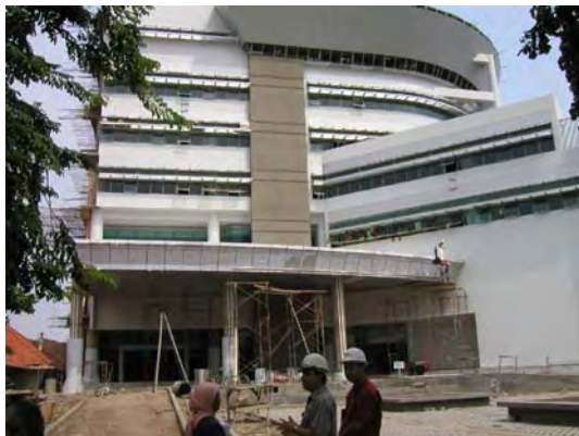
3. ストモ病院の新棟建設 同病院の新棟のラボラトリーは、本プロジェクトの研修室として検討されたが、スペース不足のため、アイルランガ大学を研修ユニットとして整備する。
