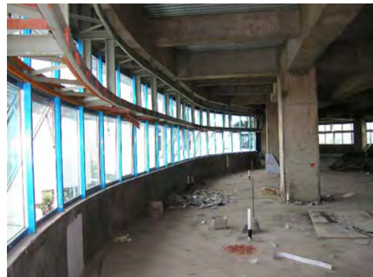
4. ストモ病院の新棟の内部 同病院の新棟は、一般検査・診断サービスを行う計画である。写真は新棟の4階でラボラトリーを予定している。
