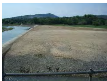
Diversion Dam 付近 ダムがほとんどが土砂で埋まっている
