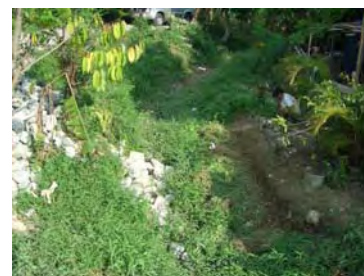
幹線水路下流部 草が生い茂っていて、どこが水路か分からない状態
