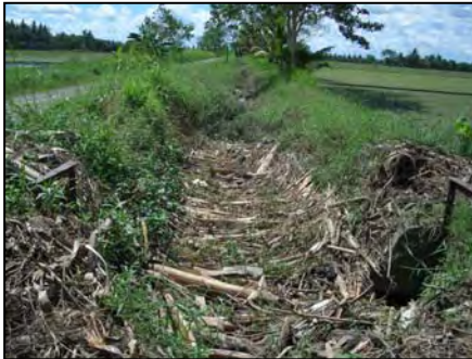
幹線水路下流部
