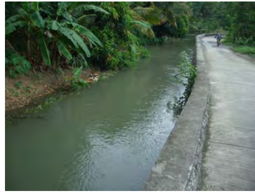
主水路下流 メンテナンスの状態は良く、水量も十分あるように見受けられた
